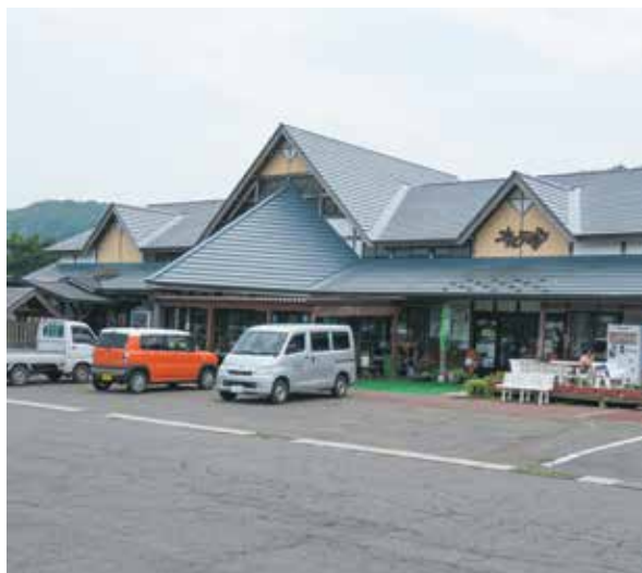
増改修工事が行われるオドデ館
