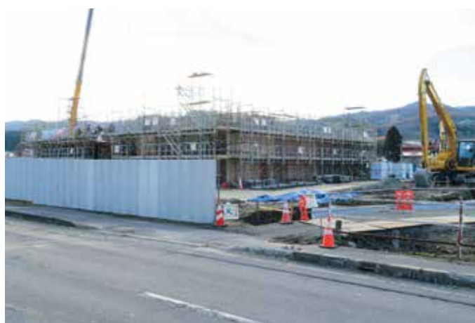
新しい九戸分署の工事が進められている
