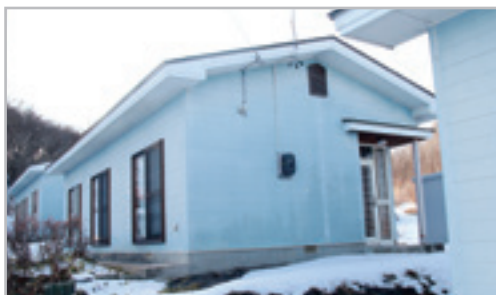
村営住宅第2小倉団地
