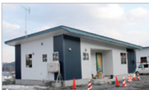
長興寺若者定住促進住宅 (建設中)
